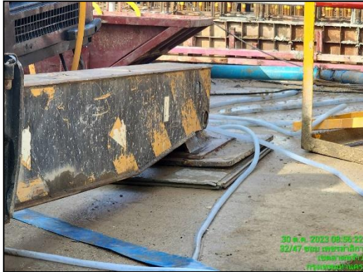
ภาพที่ 51 วัสดุรองใต้เครื่องจักรลดการสั่นสะเทือน
