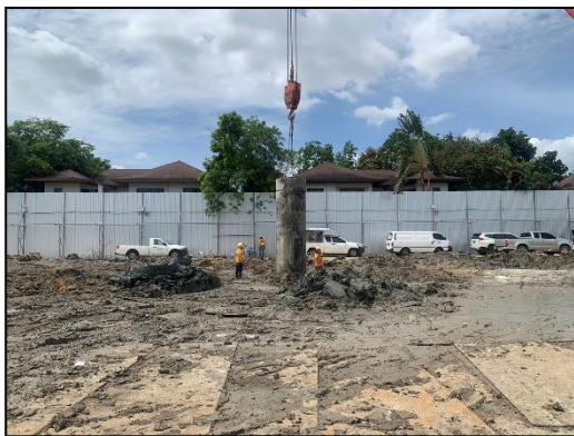
ภาพที่ 19 เส้าเข็มเจาะ
