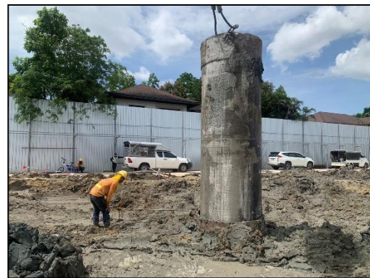
ภาพที่ 19 เส้าเข็มเจาะ
