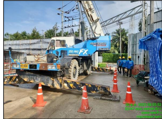
ภาพที่ 51 วัสดุรองใต้เครื่องจักรลดการสั่นสะเทือน
